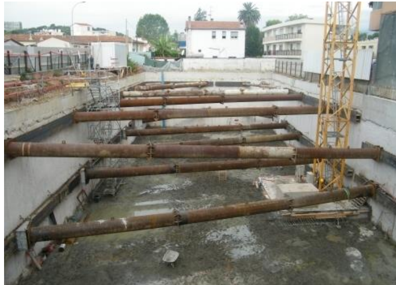
Exemple de butonnage dans un ouvrage rectangulaire
