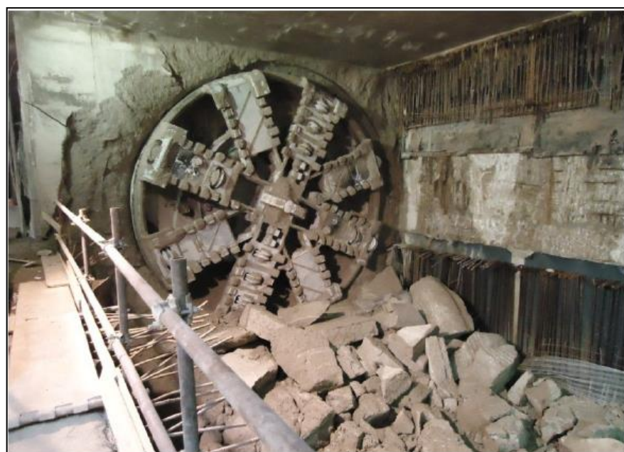
Arrivée d'un tunnelier en puits d'arrivée (Egis / Tractebel, 2016)
